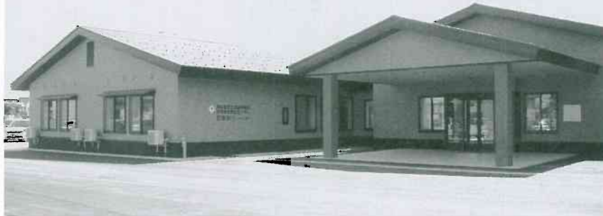
▲完成した「ひまわりショートステイ」の玄関と外観
